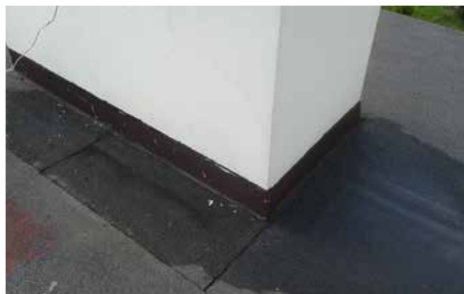
Wilgotne podłoże po umyciu dachu
