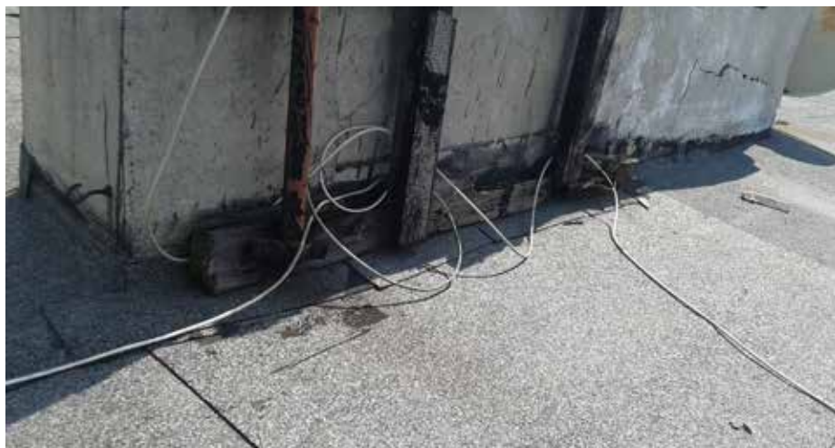
Elementy wymagające usunięcia przed wykonaniem obróbek w systemie COOL-R
