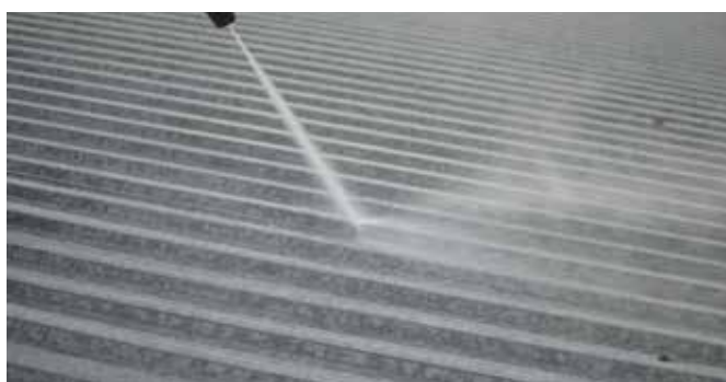
Mycie dachu – spltukiwanie aktywnej piany czystą wodą
