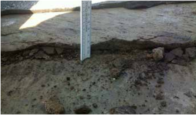
Przykładowe skutki braku wykonania dylatacji przeciwskurczowej
