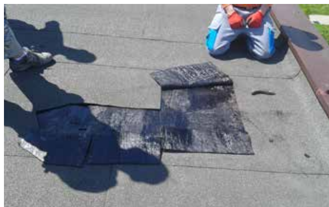
Przegląd podłoża. Usuwanie pęcherzy powietrza.
