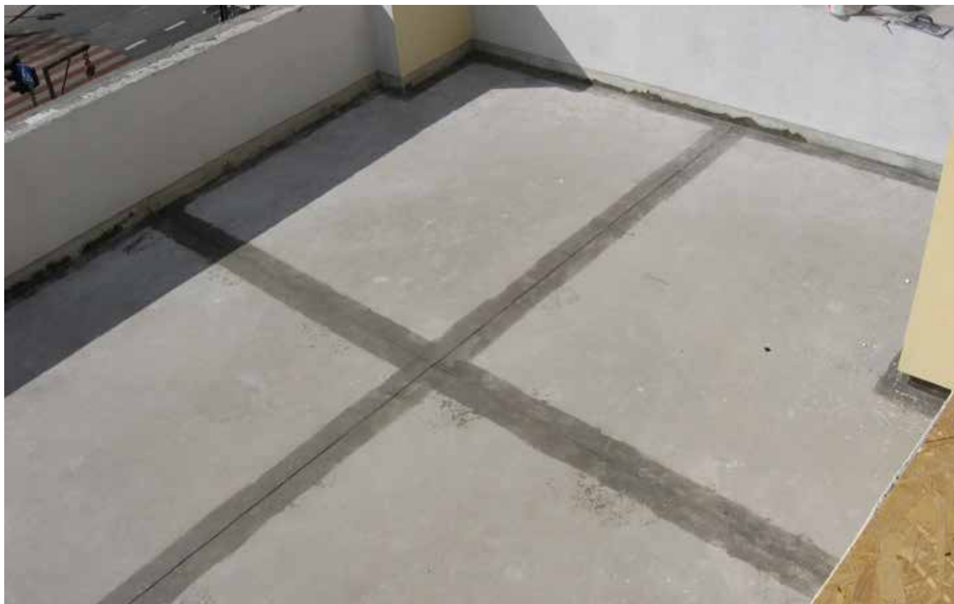
Przykładowe wykonanie dylatacji przeciwskurczowej
