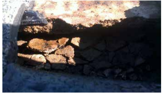
Przykładowe skutki braku wykonania dylatacji przeciwskurczowej
