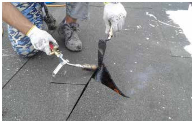
Naprawa istniejącego podłoża
