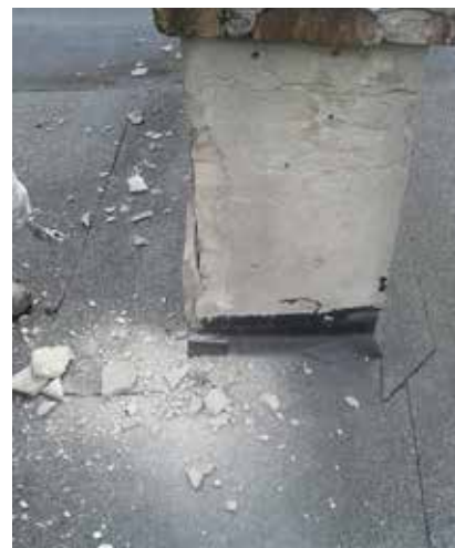
Odparzona warstwa tynku na kominie
